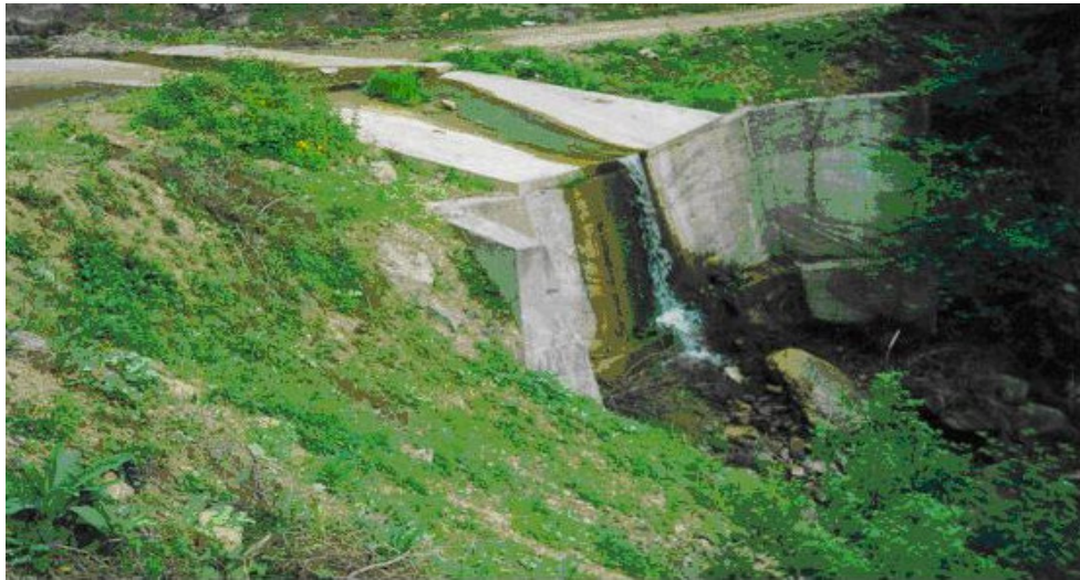
Şekil 2. Tekniğine uygun yapılmış bir kasis
